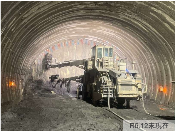
大谷トンネルの掘削状況
