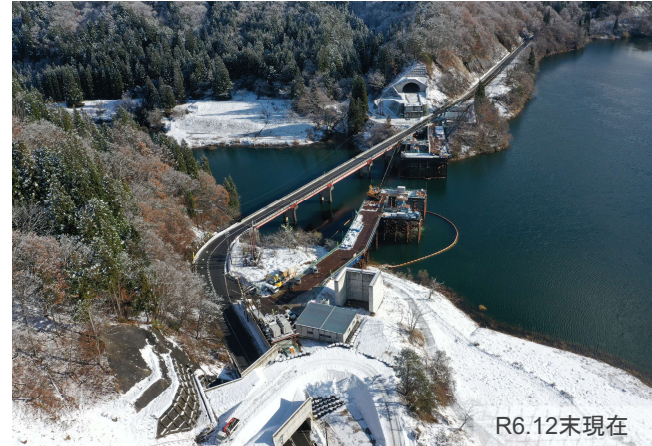
新林谷橋の状況
