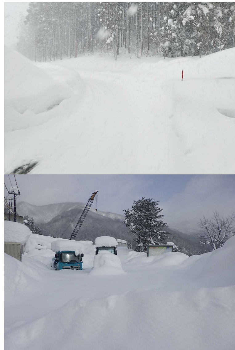
■ 写真2 新下半原トンネル工事現場の状況
