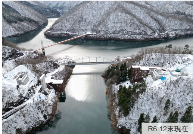
新子馬巢谷橋の状況
