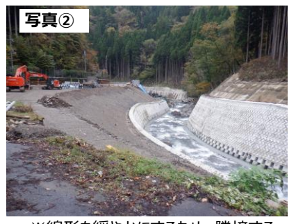
※線形を緩やかにするため、隣接する引原川を切替し、道路を施工中
