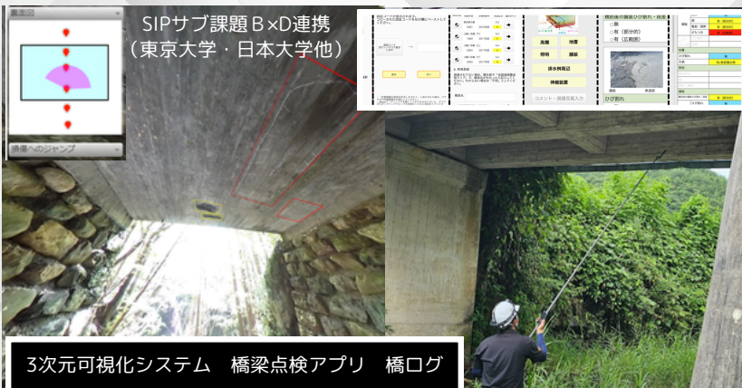
赤外線サーモグラフィ 剥離・ウキ検査
