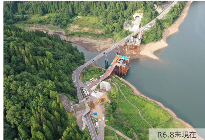
新林谷橋の状況
