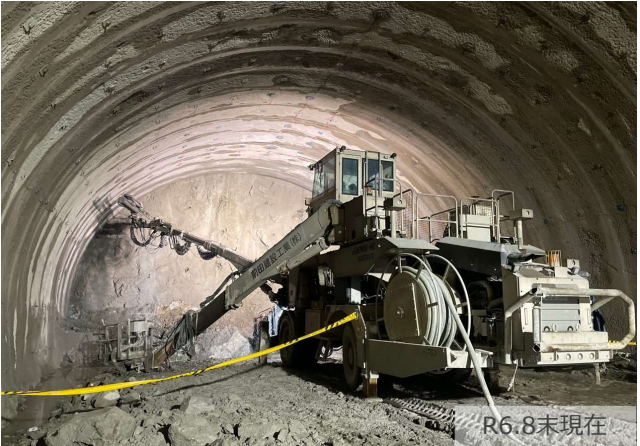
大谷トンネルの掘削状況
