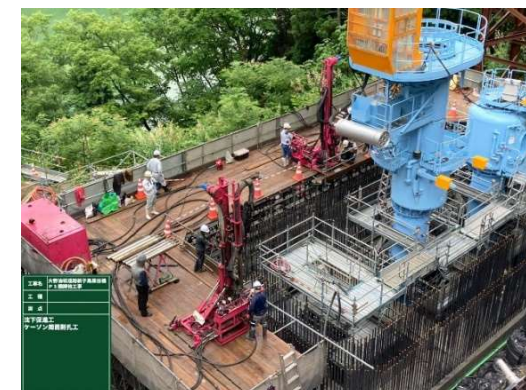
写真4 沈下不能対策工事の状況(削孔)
