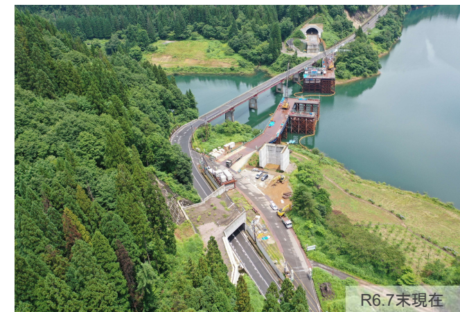
新林谷橋の状況
