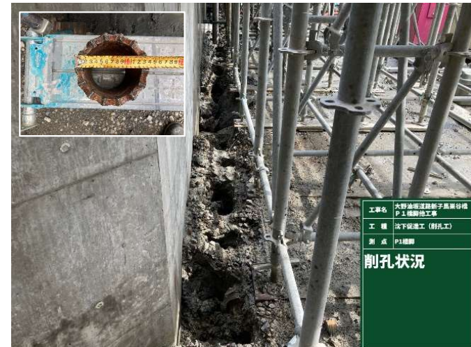
写真2 削孔した穴の状況
