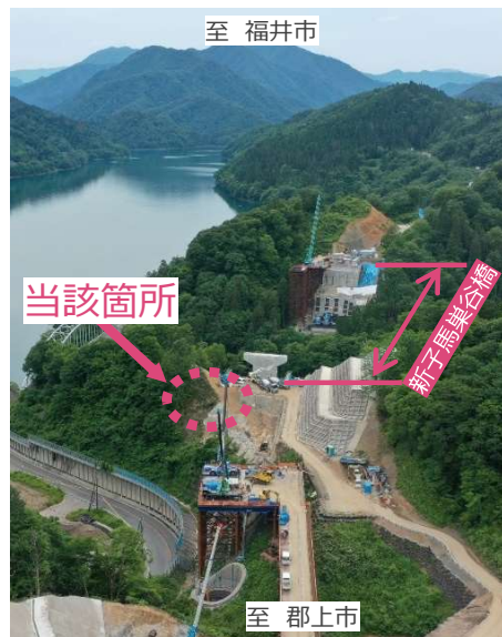
写真1 上部工事の状況
