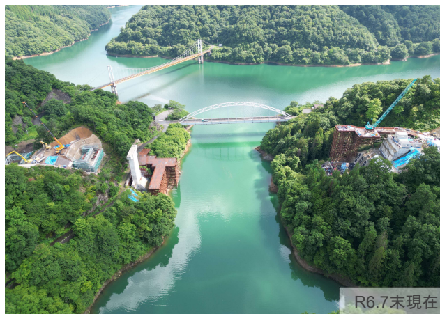
新子馬巣谷橋の状況
