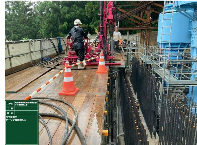
写真1 沈下不能対策工事 (削孔) の状況
