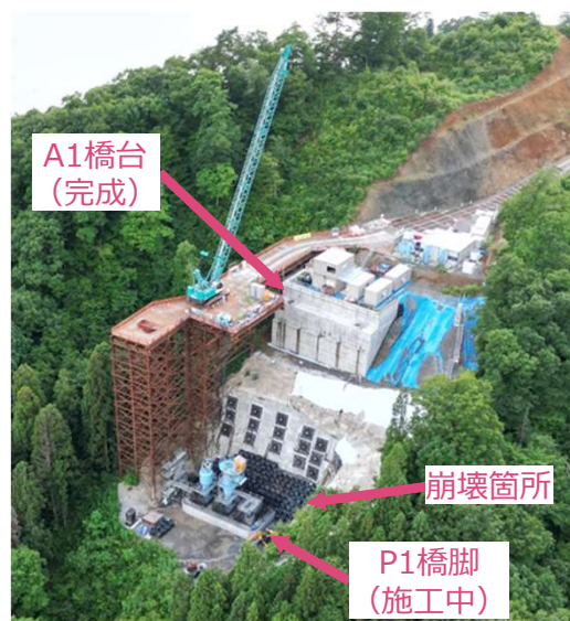
写真1 下部工事の状況
