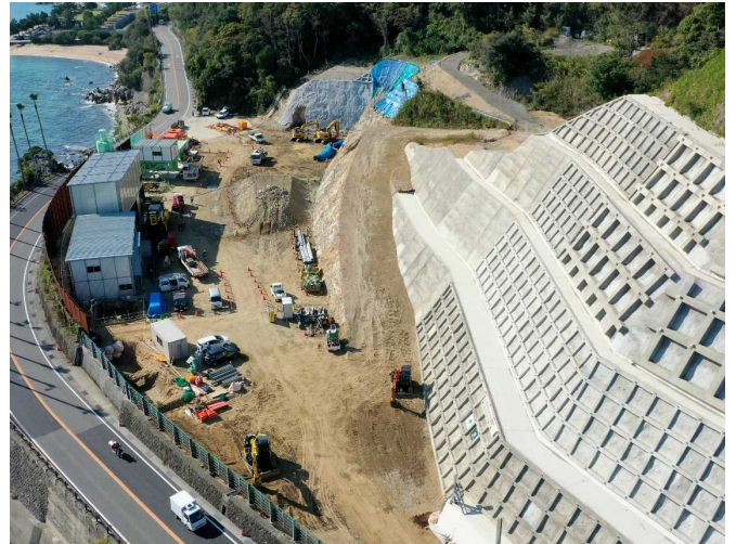
■トンネル工事着手 (令和2年11月 撮影)
