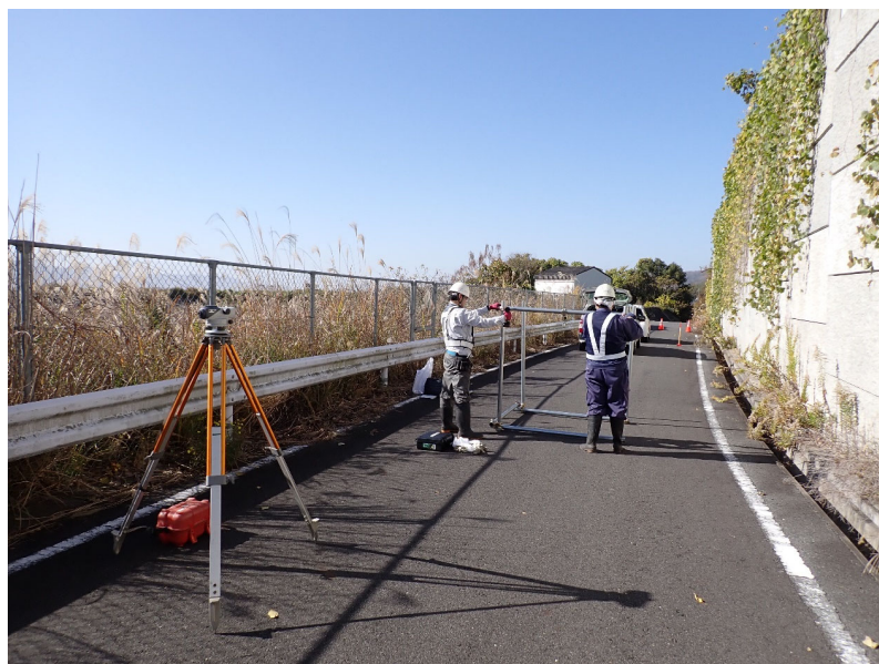
ボーリング調査
