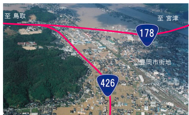
写真②: 国道178号及び426号の浸水状況 撮影日:平成16年10月21日
