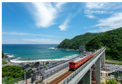
あまるべ 余部鉄橋(兵庫県美方郡香美町)
