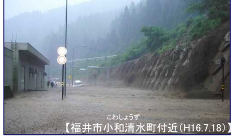
写真① 国道158号 冠水・崩落
