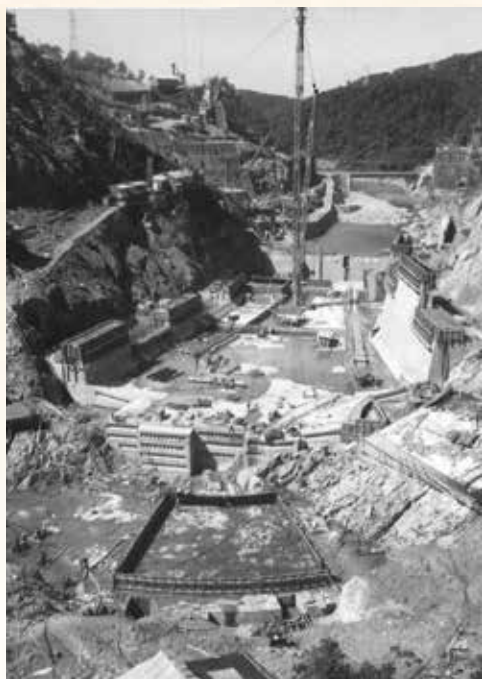
天ヶ瀬ダム建設
