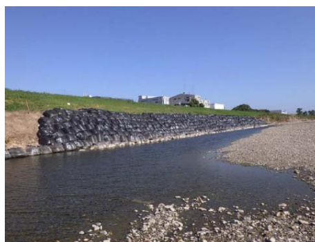
応急復旧完了
