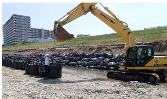
大型土のう設置 作業状況
