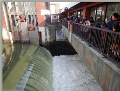
大迫力！バイパス水路
