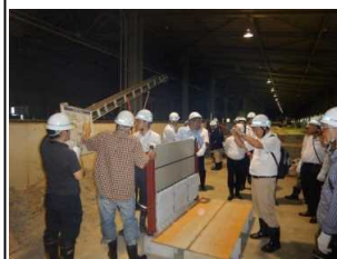
地元との密な議論・検討(左：止水壁実験状況視察、右：実物大模型を現地に設置し、景観への影響を確認)
