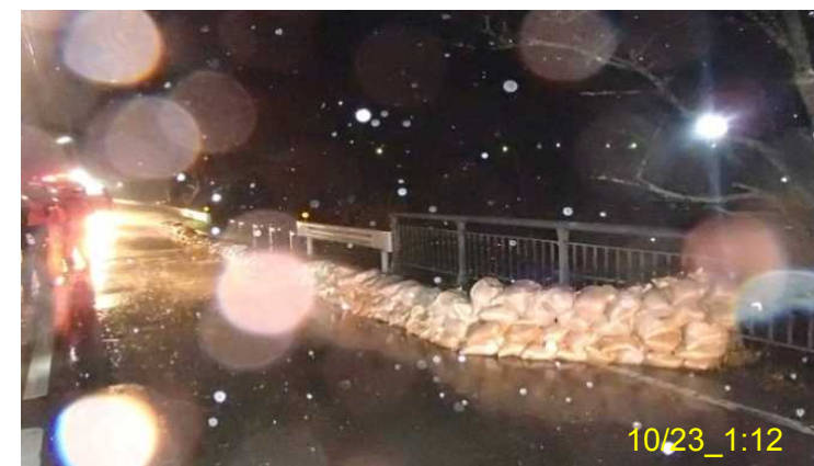
<積み土のう工完了>
