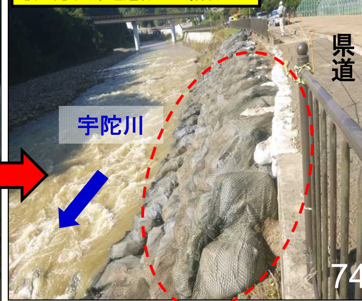
10/27 10:00頃 復旧完了(県道通行止め解除)
