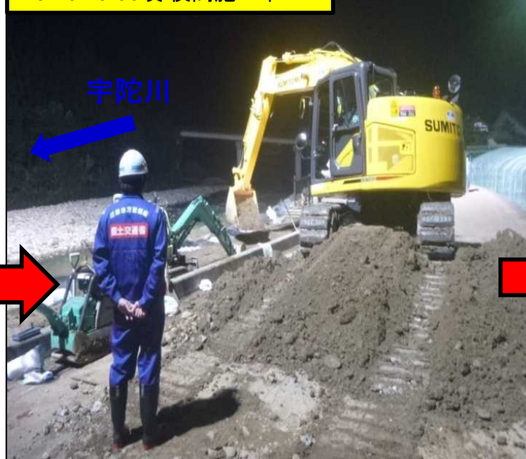
10/26 19:00頃 夜間施工中
