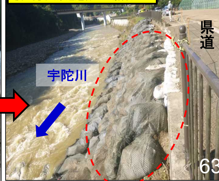
10/27 10:00頃 復旧完了(県道通行止め解除)
