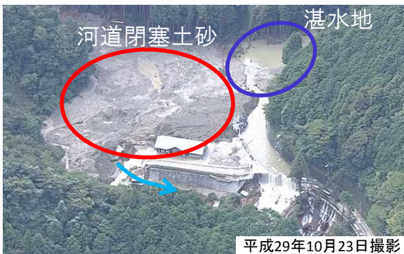
崩壊地下部の状況調査
