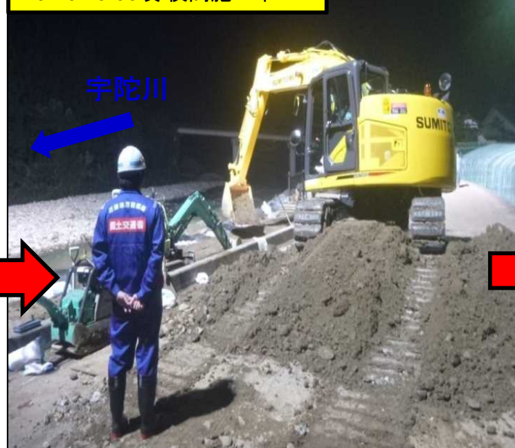
10/26 19:00頃 夜間施工中
