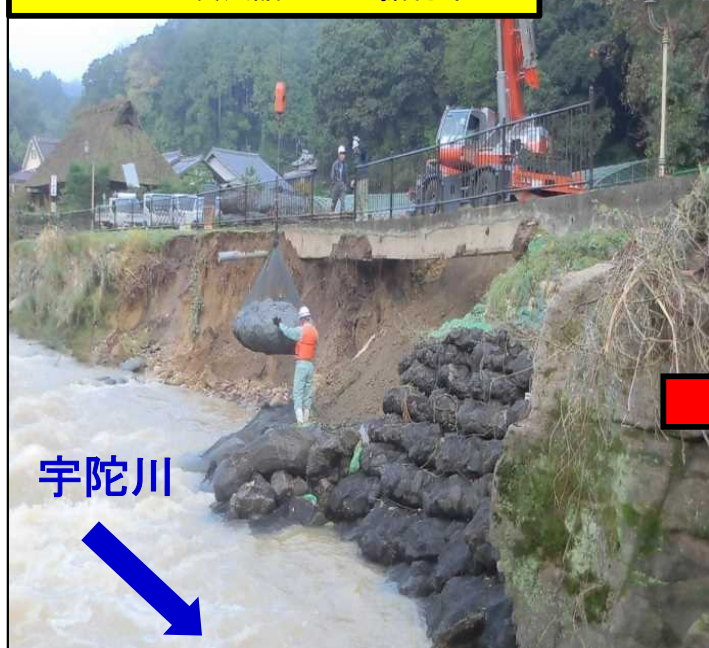
10/26 9:00頃袋詰め玉石据付中
