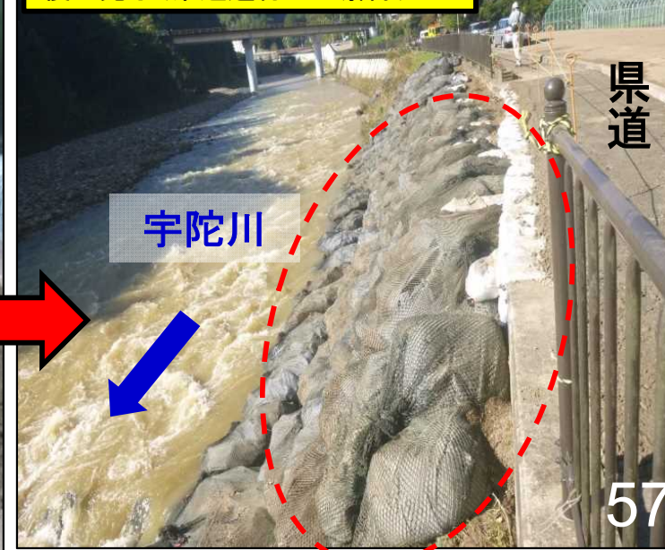
10/27 10:00頃 復旧完了(県道通行止め解除)
