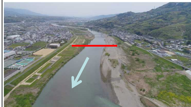
— 三谷水位観測所 断面位置
