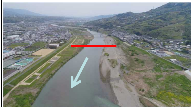
三谷水位観測所 断面位置
