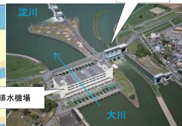
毛馬排水機場
