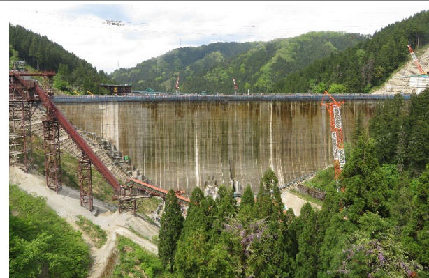
展望台から望むダム工事現場 R8.4.28撮影
