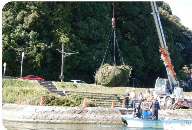
回収した水草の揚陸・仮置き作業（瀬田川右岸73.2k付近）
