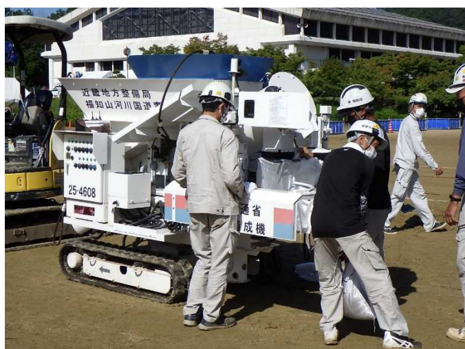
土のう造成機を用いた土のうの作成
