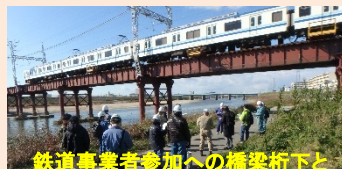
鉄道事業者参加への橋梁桁下と水位の説明 大阪府住吉区遠里小野地先 (南海高野線鉄橋)
