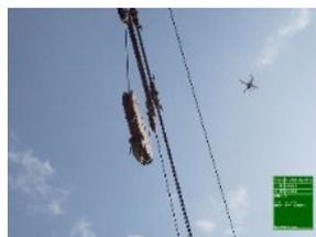
UAVによる索道設備の点検
