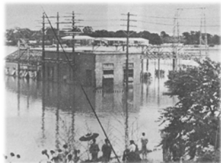
水浸しになった阪急変電所
