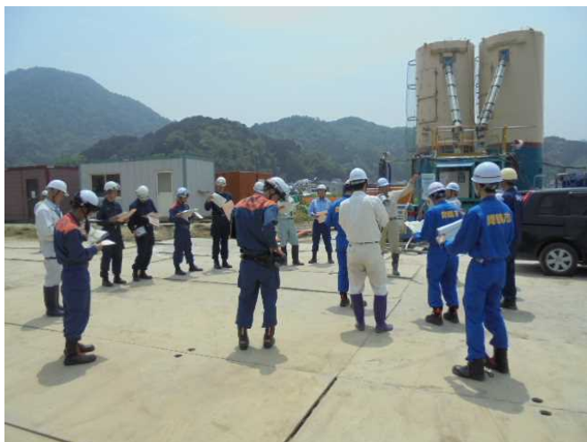
▲下東地区における工事概要説明の様子
