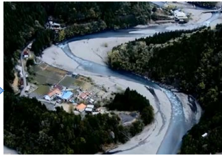
河道内に土砂が堆積
