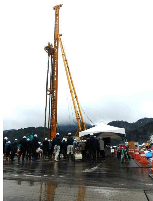
▲ 高さ約50mの地盤改良機械
