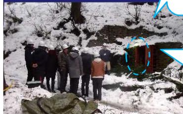
地山に横坑を掘って、技術者が直接岩盤状況を調査・観察します。
