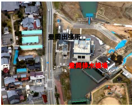
豊岡排水機場 全体写真
