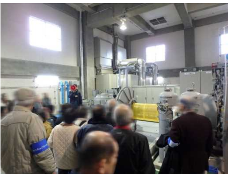
減速機等の機械設備について説明
