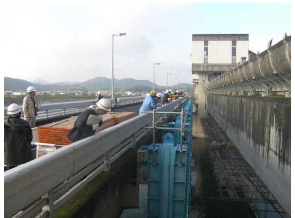
主ゲート(2号)修繕工事現場見学
