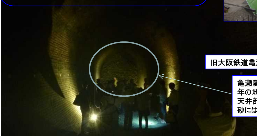
地下水を集める施設(1号排水トンネル)
