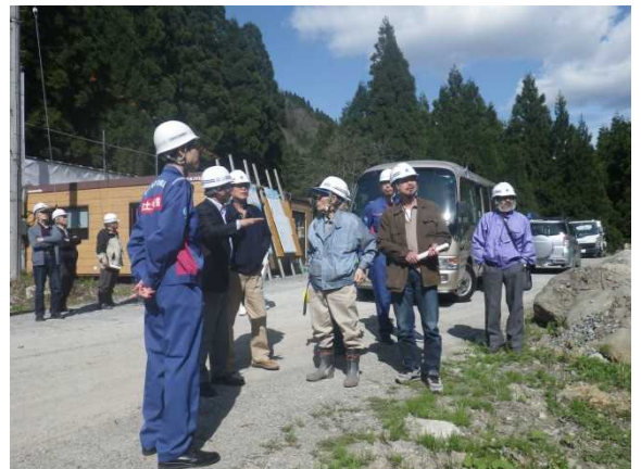
【3号工事用道路工事現場視察風景】
