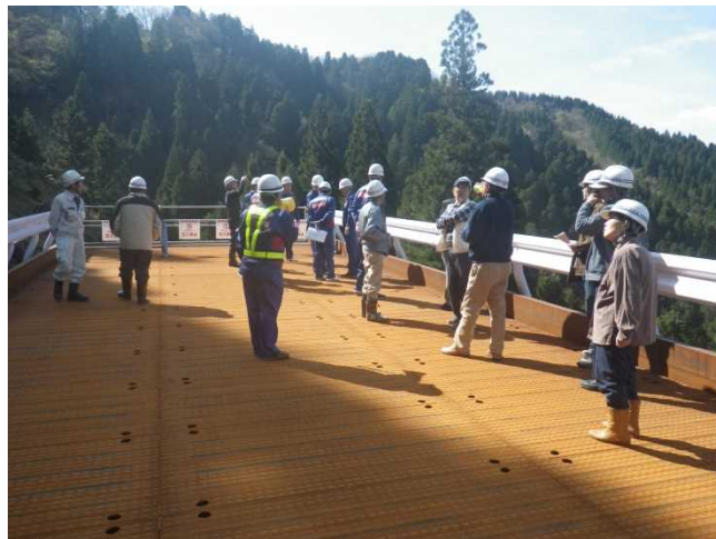
【1号工事用道路工事現場視察風景】
