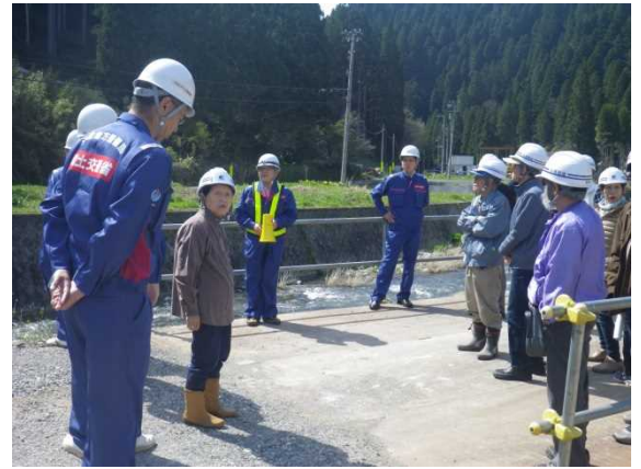
【付替県道1工区付近工事現場視察風景】
