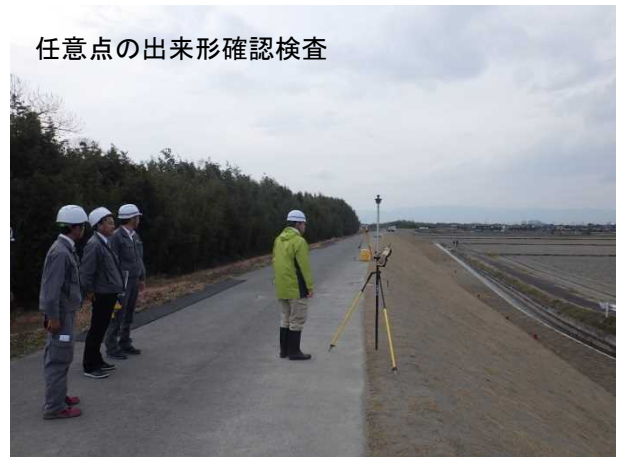
出来形管理用TSを用いた検査
