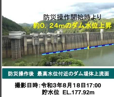
ダム貯留状況写真
