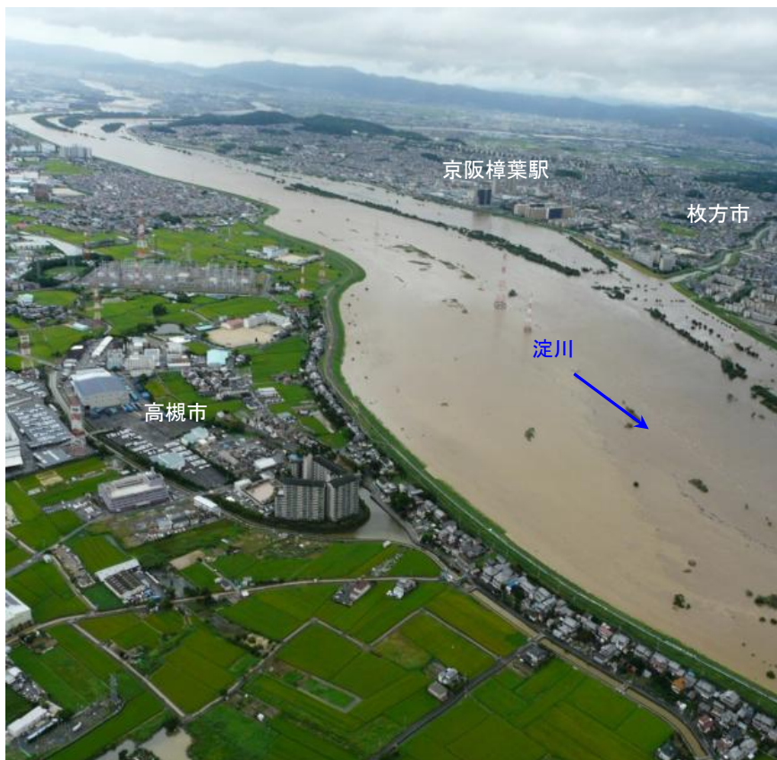
台風18号洪水により、高水敷が冠水した淀川
