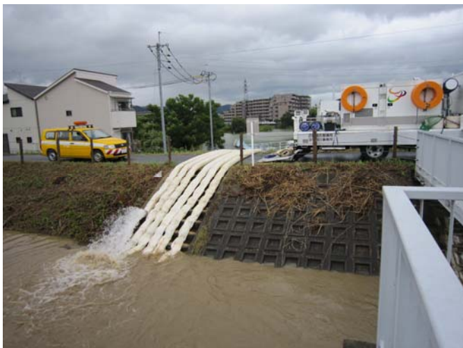
排水ポンプ車による内水排水作業(京都市伏見区 山科川)
