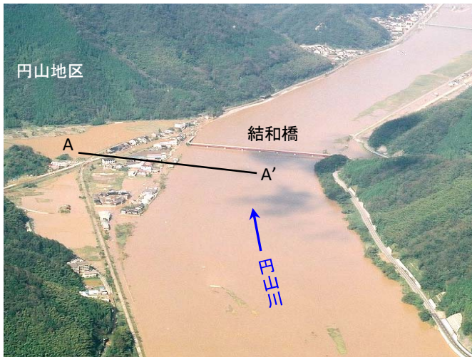
平成16年台風23号洪水の状況
