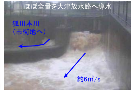
狐川分水施設導水箇所状況 (9月16日5:50頃)
