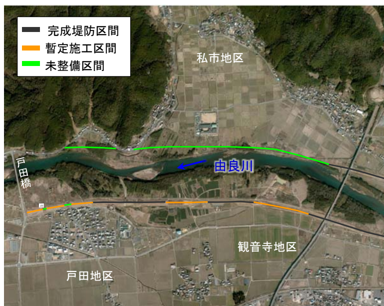
堤防整備状況
