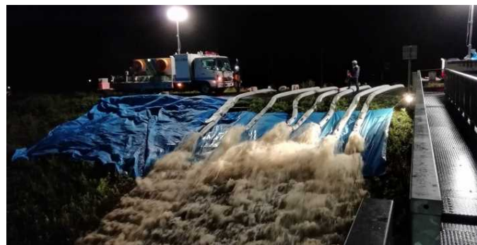
志高中央樋門 10月1日1時頃
