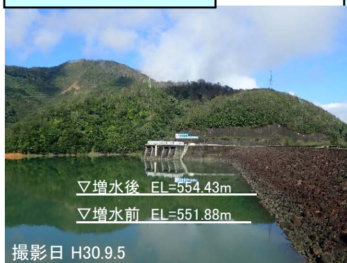
状況写真(九頭竜ダム)
