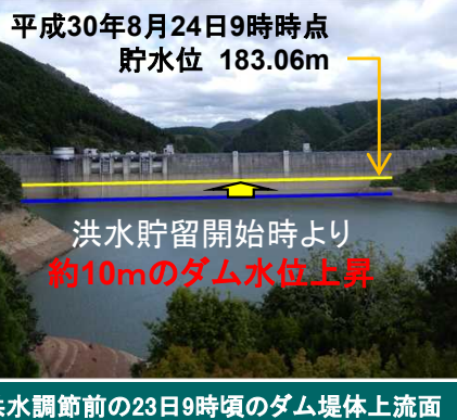
ダム貯留状況写真
