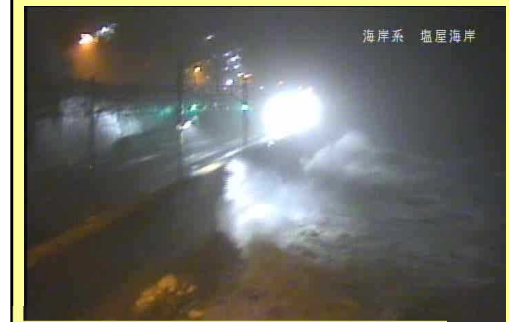
(8/23 23:00) 海岸堤防の越波状況
