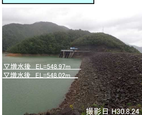
状況写真(九頭竜ダム)
