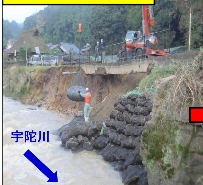
10/26 9:00頃袋詰め玉石据付中
