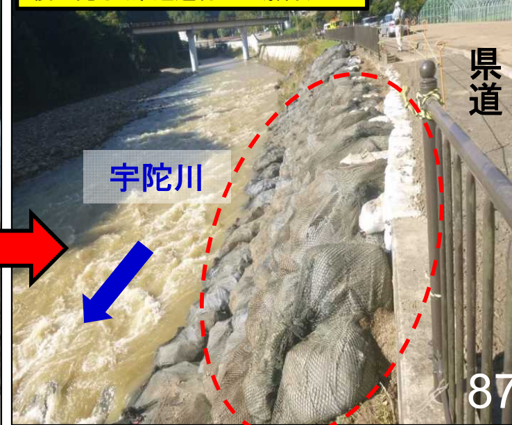
10/27 10:00頃 復旧完了(県道通行止め解除)
