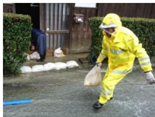
京都府久御山町では釜段工を実施し、決壊の可能性を回避した。
