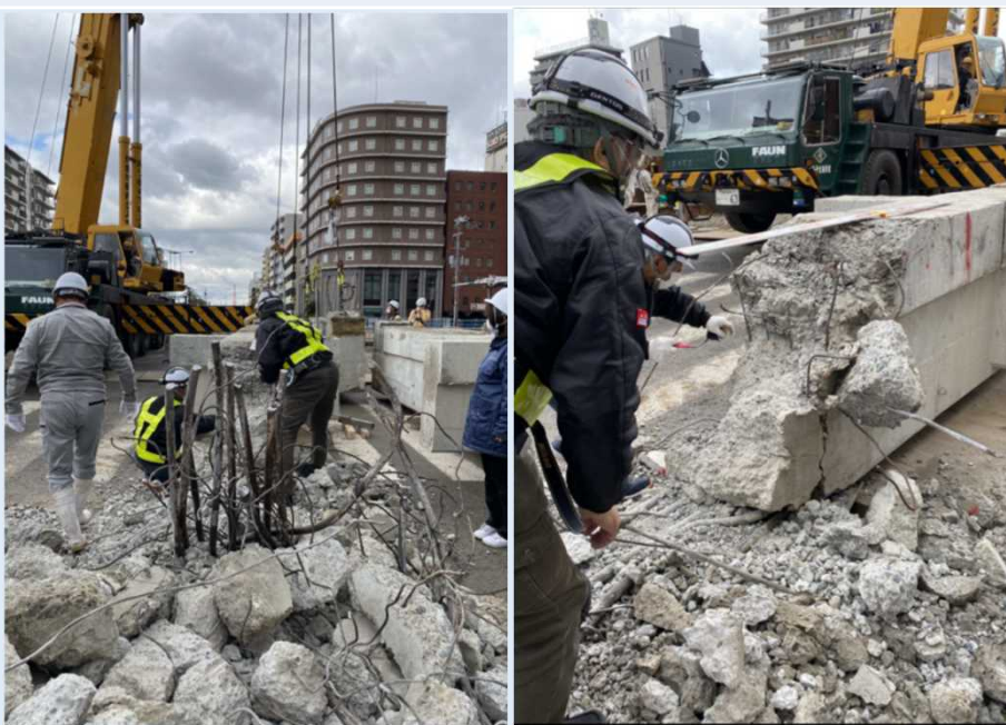
図-2 現場確認（鉄筋位置、径の確認中）
