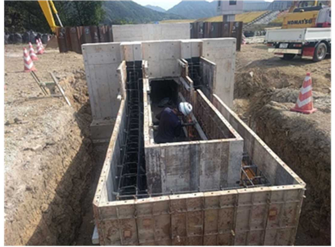
鋼製型枠工事近景
