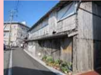
空き家の除却
