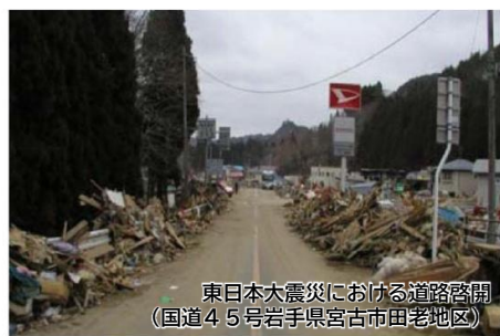
[道路啓開後の状況]
