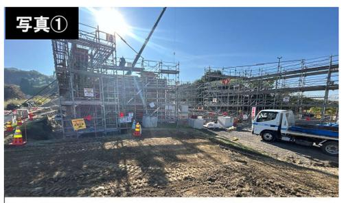
↑ 青谷川橋の橋梁下部工(A2)がR7.3に完了し、続いてA2橋台南側で函渠工事を進めています。
