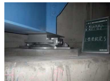
写真-5.7 上塗塗装完了
