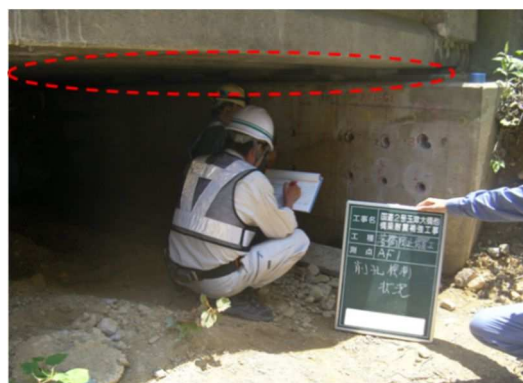
写真-5.1 現地状況
