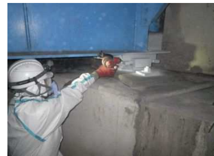
写真-5.5 金属溶射状況
