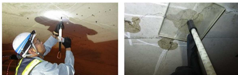
写真-7.6 施工状況 (QS-170029-A)
