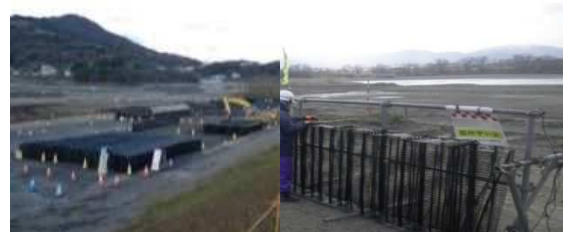
写真-5.8 組立て状況
