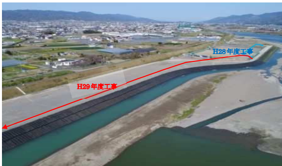
写真-5.9 完成状況
