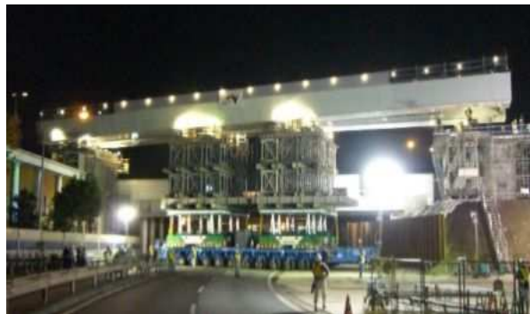
写真-7.2 多軸式特殊台車を用いた一括架設
