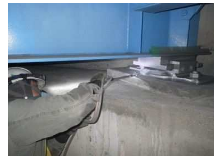
写真-5.6 上塗塗装施工状況
