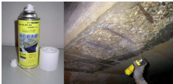
写真-7.4 施工状況 (KT-120036-VE)
