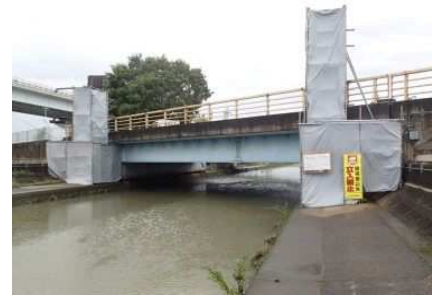
写真-5.3 飛散養生
