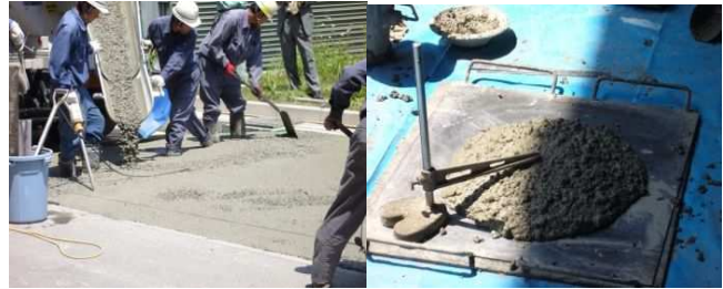
写真-7.8 施工状況 (左) とスランプフロー (右)
