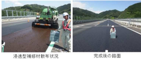
図-7.29 浸透型補修工法の概要
