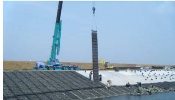
写真-5.10 施工状況
