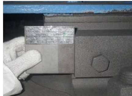
写真-5.4 素地調整完了
