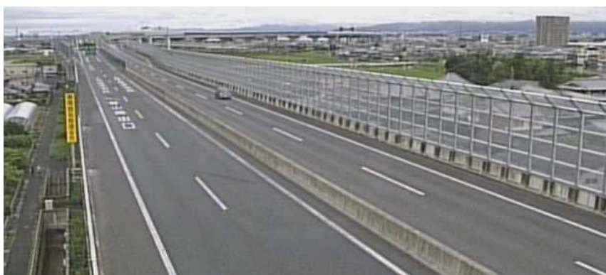
写真-4.1 透光性遮音板設置のイメージ（京奈和自動車道 50kp 付近）
