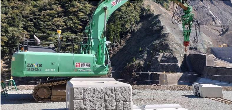
砂防堰堤のブロックを自動把持するデモンストレーション
