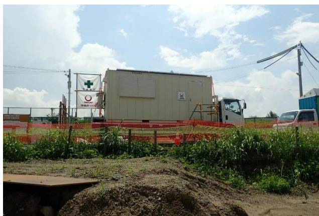
写真-3 現場仮設ソーラーシステムハウス (ハウスは車載型です)
