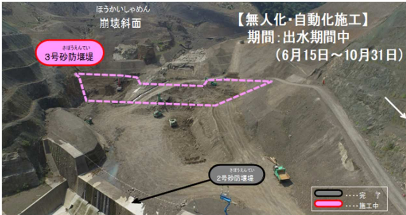
図-5 赤谷3号砂防堰堤工事の状況
