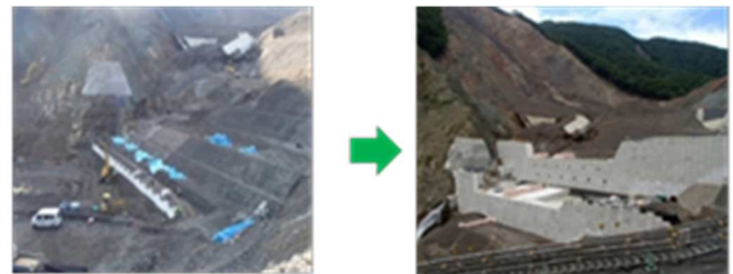
図-10 砂防堰堤(本体)のソイルセメント部が約4ヶ月で完成
