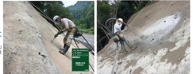
写真-4 施工状況
