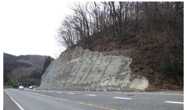
写真-5 完成写真(滋賀方面→金沢方面)
